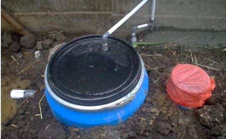
**Gambar 2.3** Instalasi Produksi Biogas Sederhana
